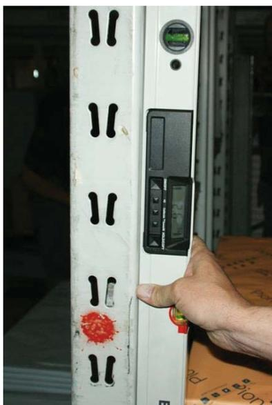
Schiefstellung einer Stütze 2,6 % aufgrund defekter Sicherung der Fußplatte gegen Verschieben; gemessen mit digitaler Wasserwaage
